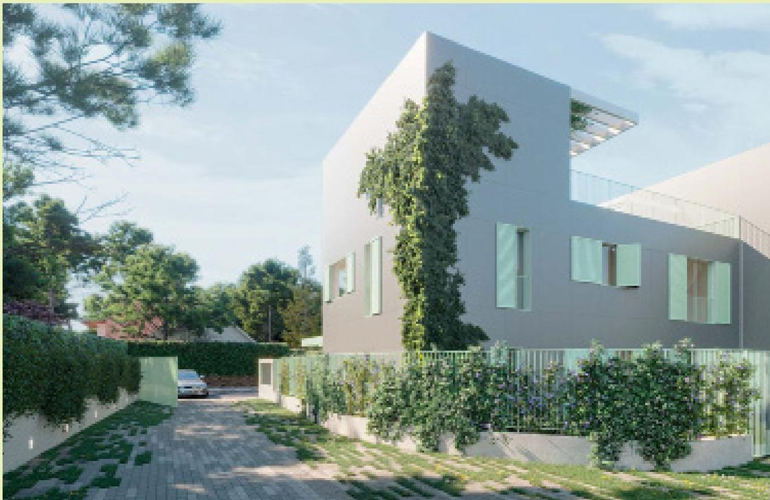
Las fachadas contienen tres capas: el trasdosado interior de doble placa de cartón-yeso tipo P ladrur con cámara para instalaciones; el alma portante de hormigón prefabricado con los aislantes térmicos y acústicos incorporados terminado con mortero de cemento; y el acabado exterior con paneles de resina termo endurecida o similar que se dispondrá con cámara ventilada evitando los puentes térmicos para proteger la inercia de los cerramientos y asegurar el confort térmico de las casas.
